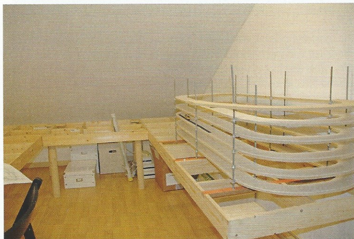
De tafelconstructie met de 41 cm hoge klimspiraal uit 12x M8 draad en een stijging van 2,1%.
